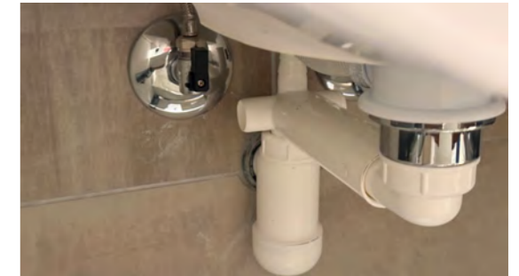
Kontroll av røropplegg.
