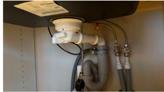
Kontroll av røropplegg.
