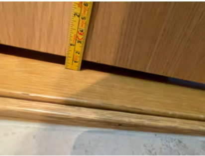
Kontroll av høyde på luftespalte under døren.
