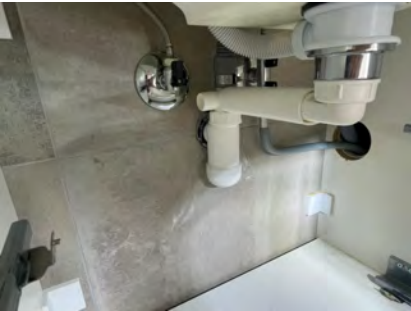
Kontroll av røropplegg.
