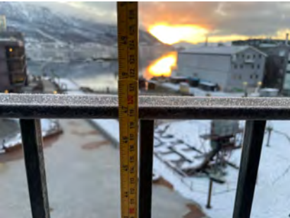
Kontroll av rekkverkshøyde.
