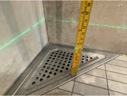
Kontroll av fall mot sluk.
