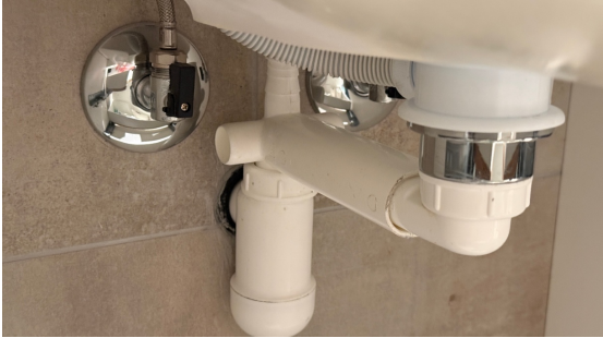
Kontroll av røropplegg.
