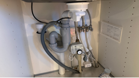
Kontroll av røropplegg.
