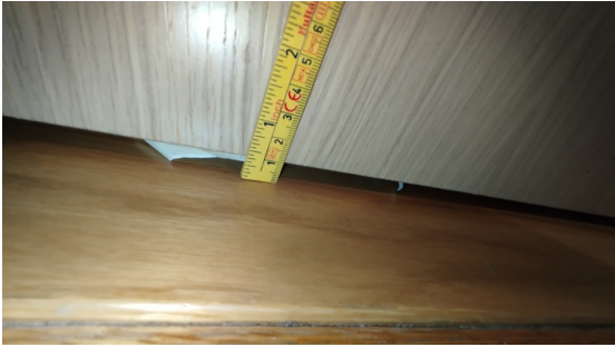
Kontroll av høyde på luftespalte under døren.
