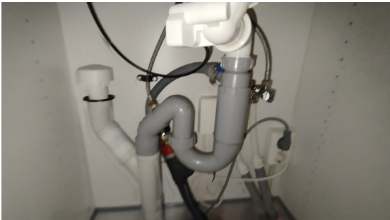
Kontroll av røropplegg.
