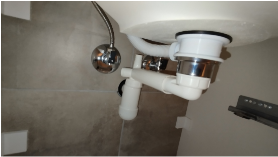
Kontroll av røropplegg.
