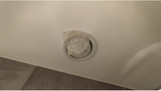
Funksjonstest av avtrekk.
