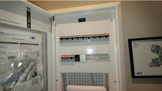
Kontroll av el-skap.
