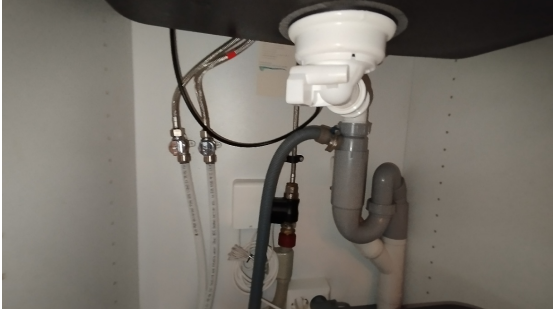
Kontroll av røropplegg.
