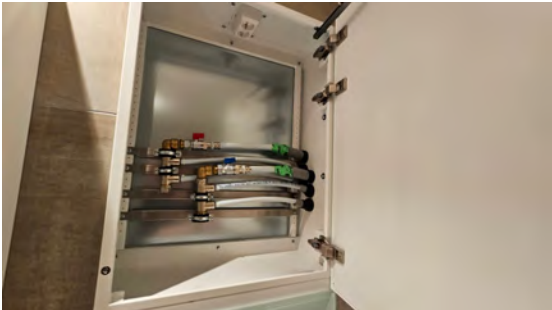
Kontroll av rørskap.
