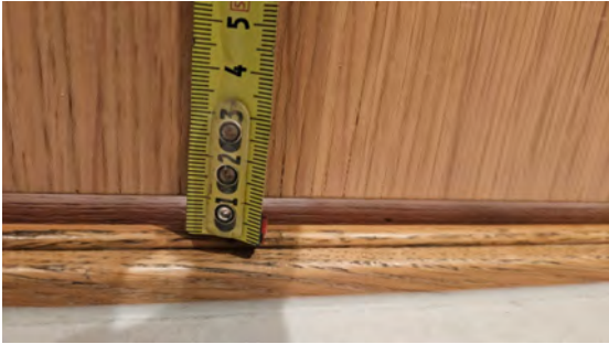
Kontroll av høyde på luftespalte under døren.
