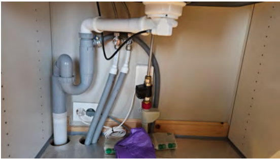
Kontroll av røropplegg.
