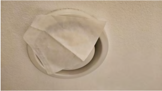
Funksjonstest av avtrekk.
