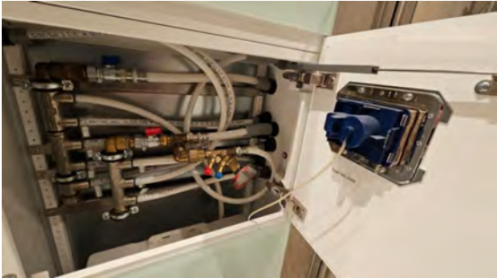
Kontroll av rørskap.
