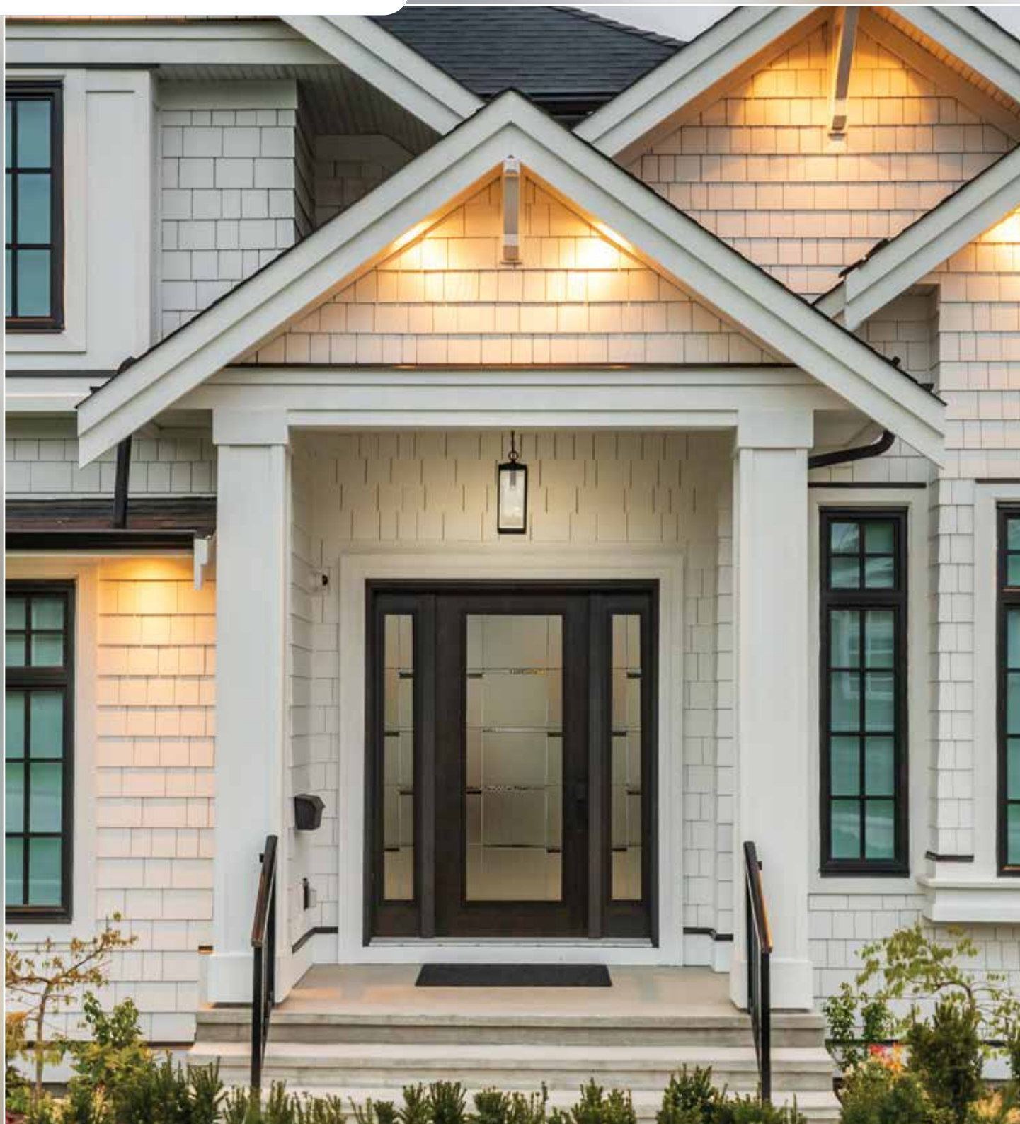
EXTERIOR DOOR OVERVIEW
