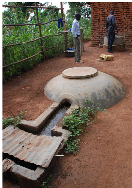
Water tower Photo : Programa Comunitário para Acesso a Energias
