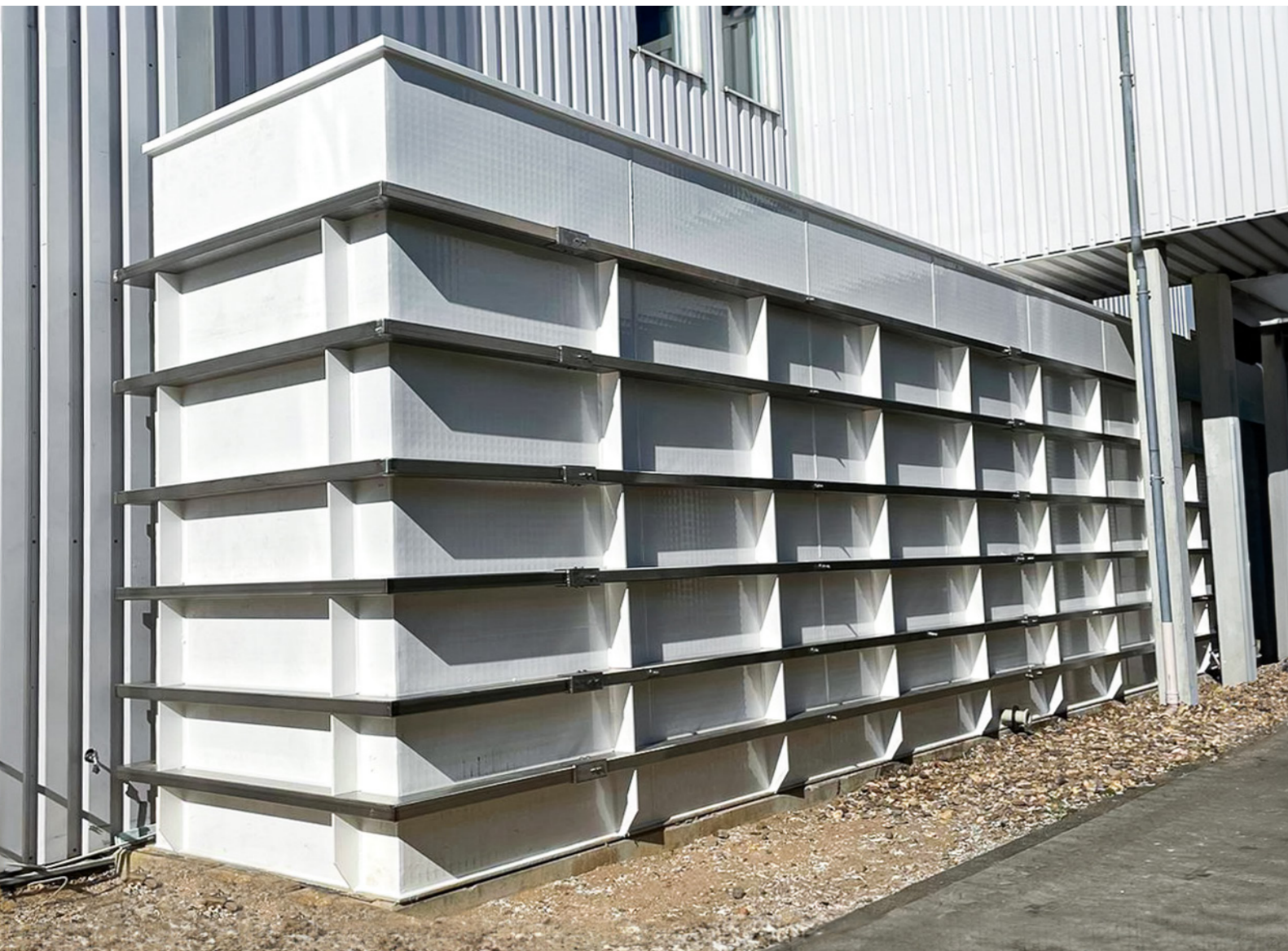
Abwasserspeichersystem: Gehört mit seinen 100 Kubikmetern Fassungsvermögen zu den sehr großen Behältern dieser Bauweise
