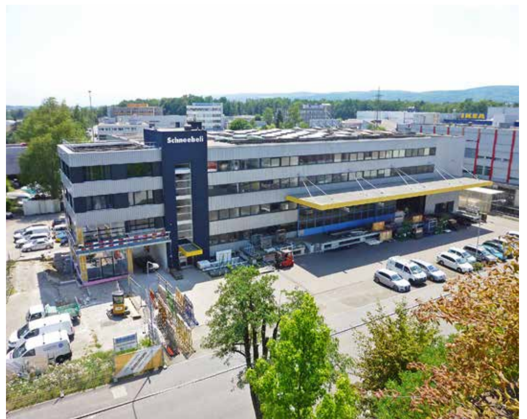
Büroanbau (links) in Fertigstellungsphase, Juli 2018
