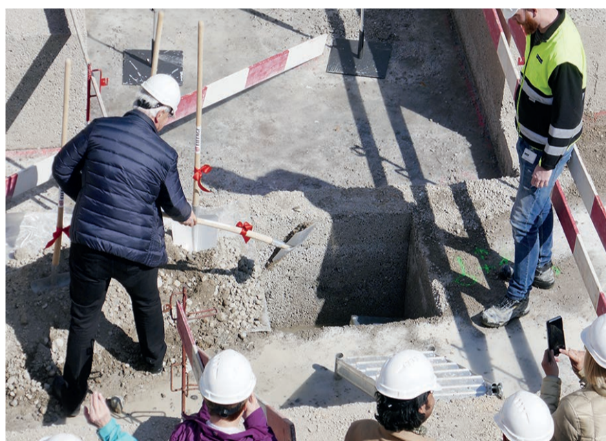
Die Zeitkapsel wird einbetoniert.
