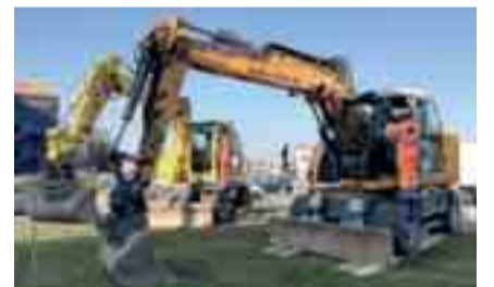
Gemeindepräsidentin Edith Zuber und Regierungsrat Markus Kägi eröffnen die Bauarbeiten
