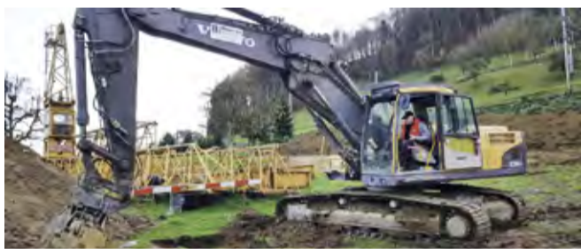
Der Spatenstich fand am 16. November 2020 statt, die Eröffnung ist für den Frühling 2022 geplant.
