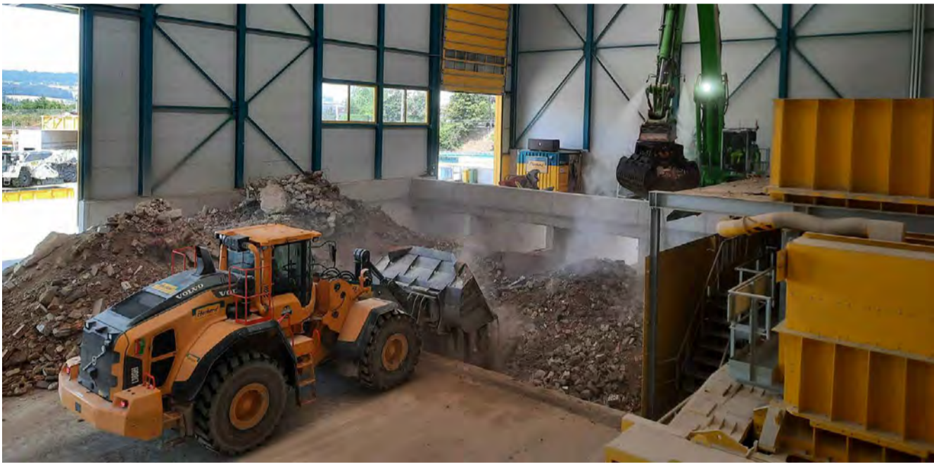
Ein Bagger und Sennebogen (grün) beim Vorsortieren von Bauabfall.
