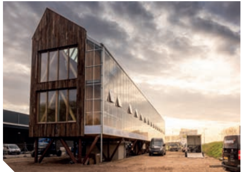
Energiehuis Deltawind tijdens de bouw, met aan de rechterzijde de inpandige kas. Foto: Bergh Bouwsystemen
