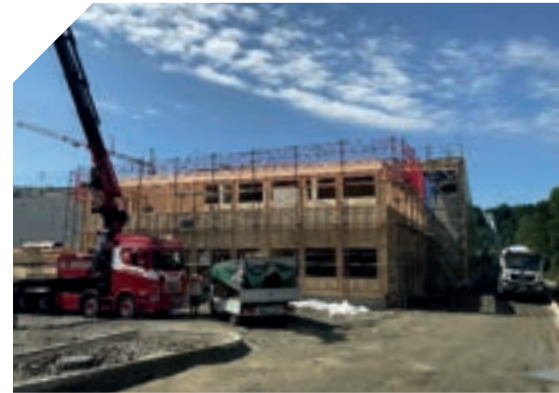
Een kantoorgebouw met distributiehallen in Sankt Stefan ob Leoben. Uitgevoerd in gelamineerde houtconstructie met CLT wanden en vloeren
