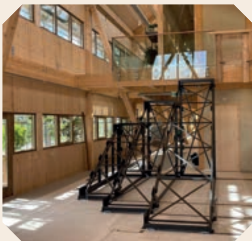
Eén van de blikvangers binnen het Energiehuis: de uitschuifbare tribunetrap van CLT en GLH.
