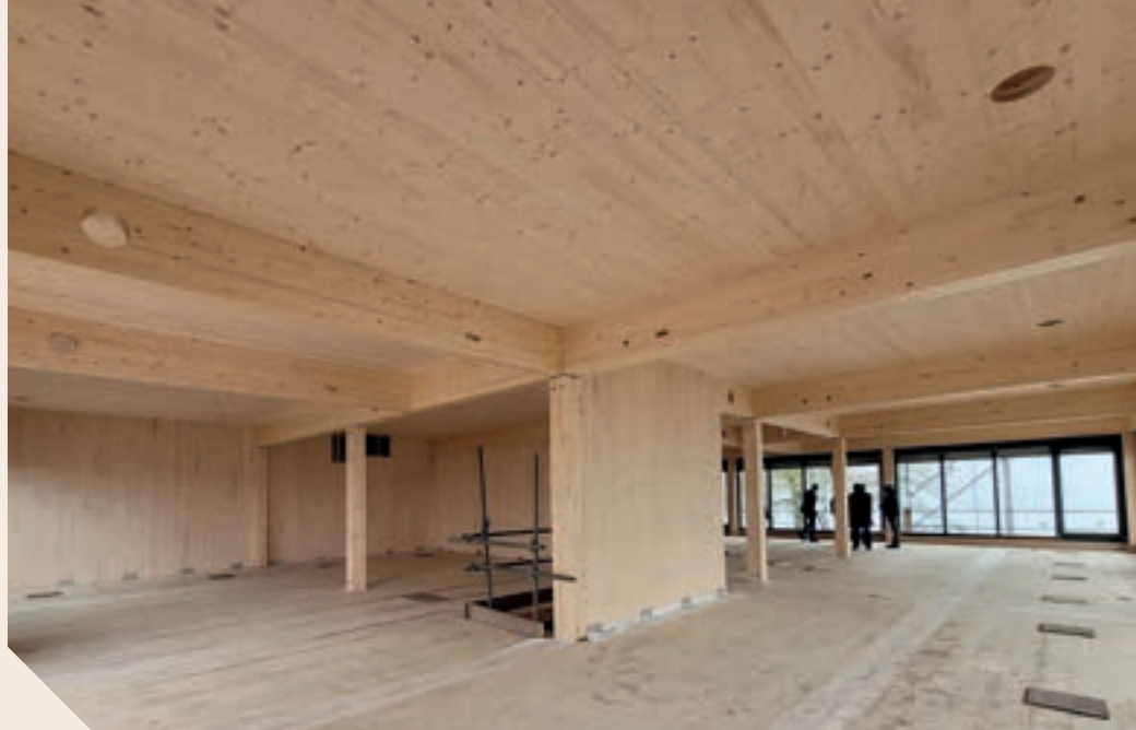
Gelamineerde houten liggers en kolommen, gecombineerd met CLT-vloeren en -wanden. Foto: BanGroep
