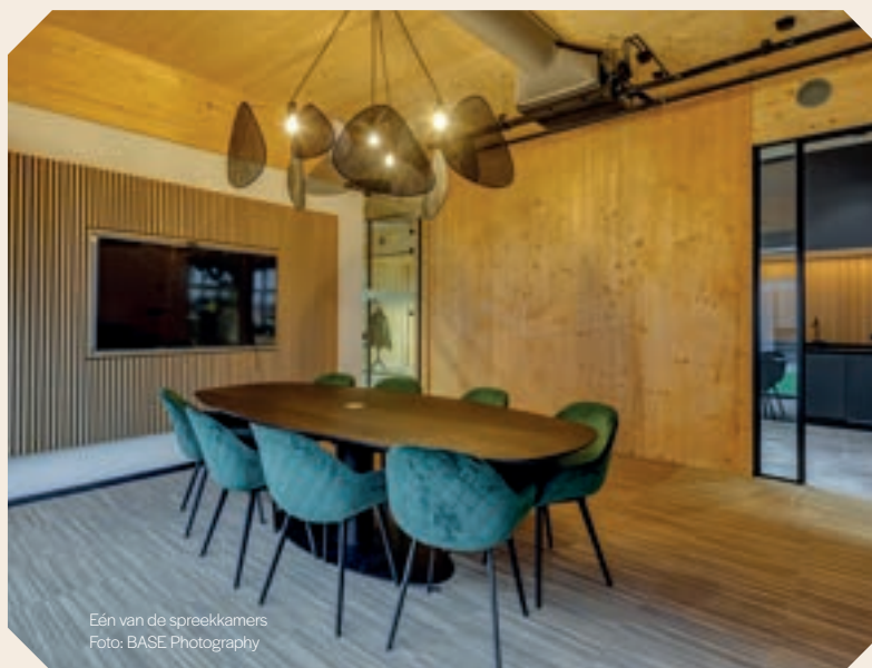
Gelamineerde houten liggers en kolommen, gecombineerd met CLT-vloeren en -wanden. Foto: BanGroep
