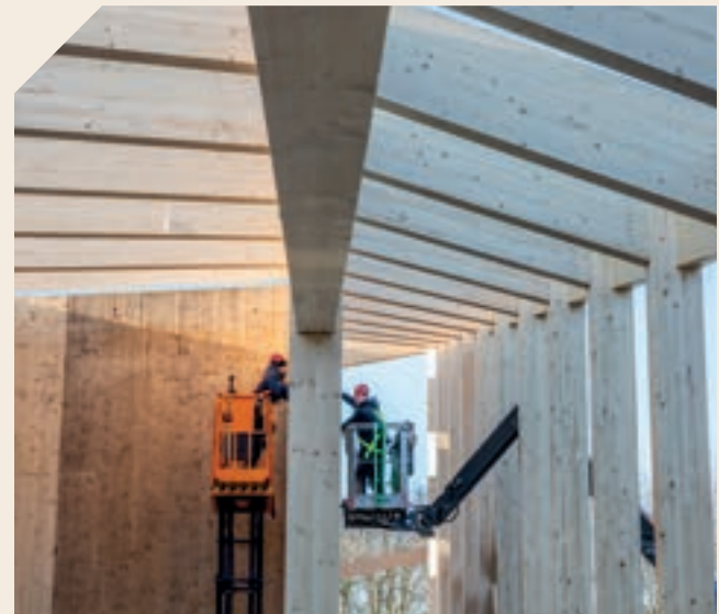
Montage uitgevoerd door onze partner Golfplaatmontage Zuid.
