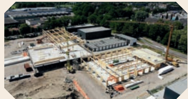
Dronefoto tijdens de bouwperiode met op de voorgrond het kantoorgedeelte en links het warehouse.
