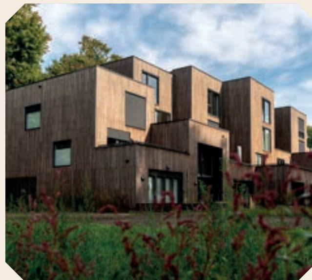
Cluster De Kruin, bestaande uit 8 woningen Linksonder het houten casco van dit cluster Foto: BASE Photography
