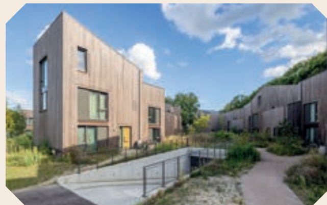
Eén van de clusters met ondergrondse parkeergarage
