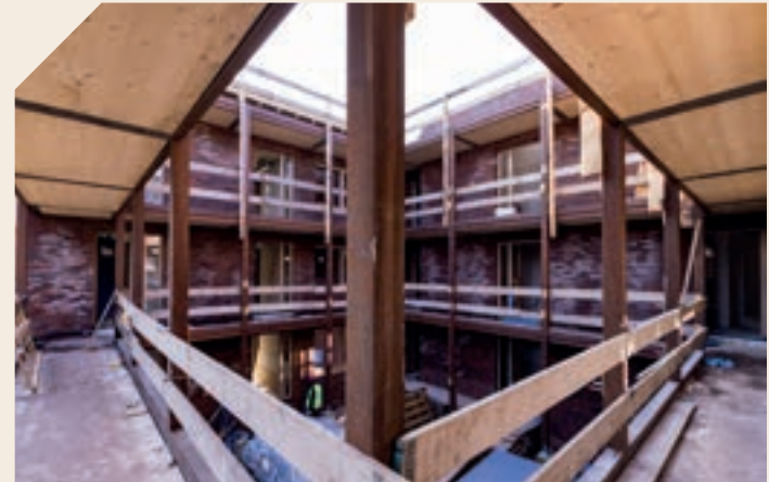
De galerij van Orthen-Links fase 4 met daarop de CLT plafondplaten. Foto gemaakt in maart 2026, voor het aanbrengen van de hergebruikte stalen hekken. Foto: Photo Prestige – Edwin van Zandvoort
