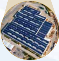
Kütahya KMK KAĞIT A.Ş ÇATI GES 3.800 kWe / 3.869,10 kWp
