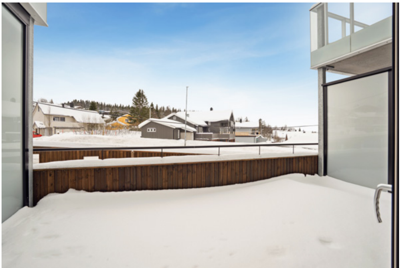
Utgang til en balkong mot sør, samt en balkong mot nord.
