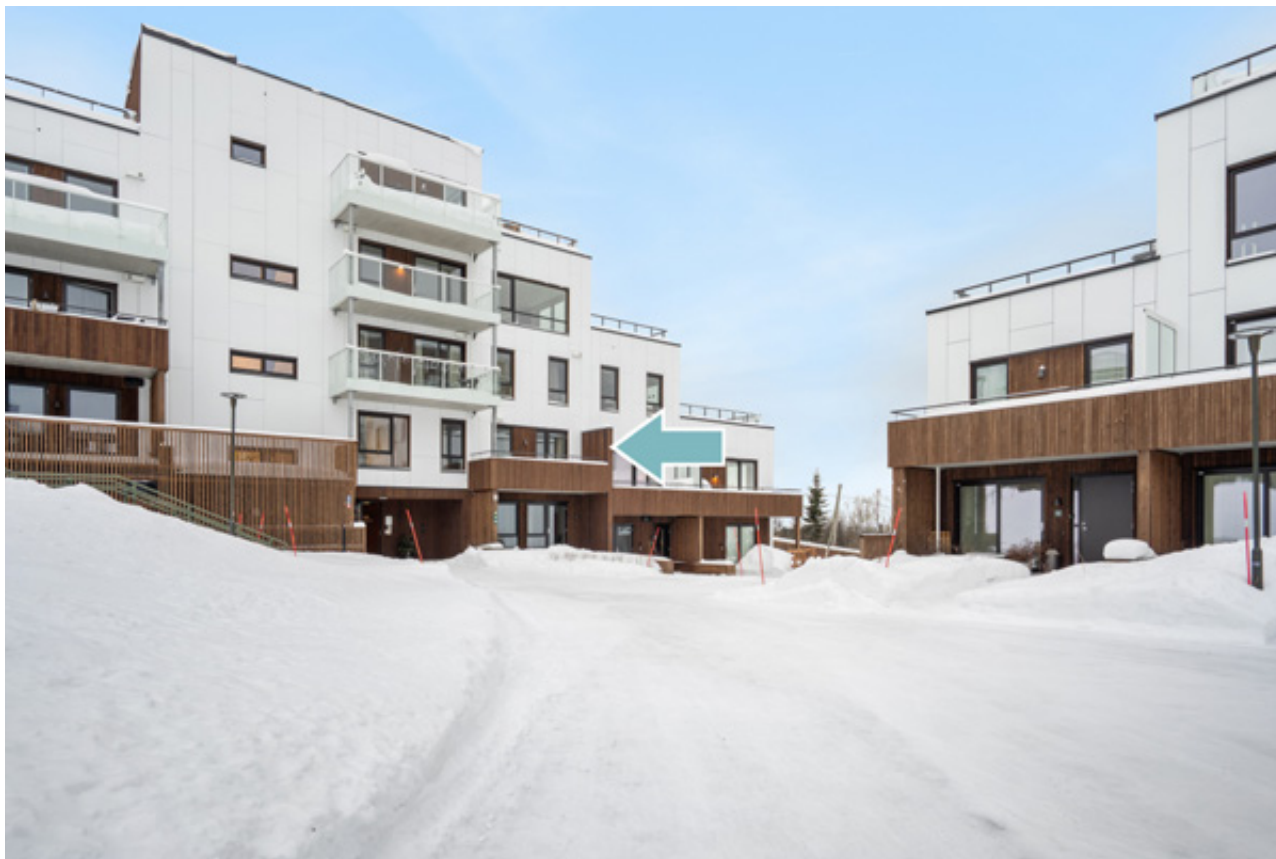
EIR har to innganger, hvor denne leiligheten har inngang i den nedre delen.
