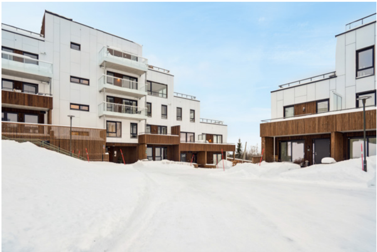
Inngang via nedre inngangsparti til blokken.
