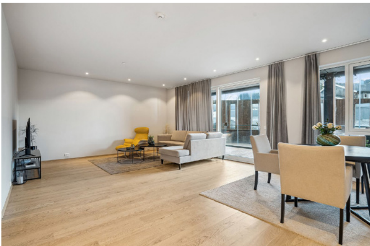
Enstavs parkett, takhøyde 2,55 m med nedforet himling med spotter.
