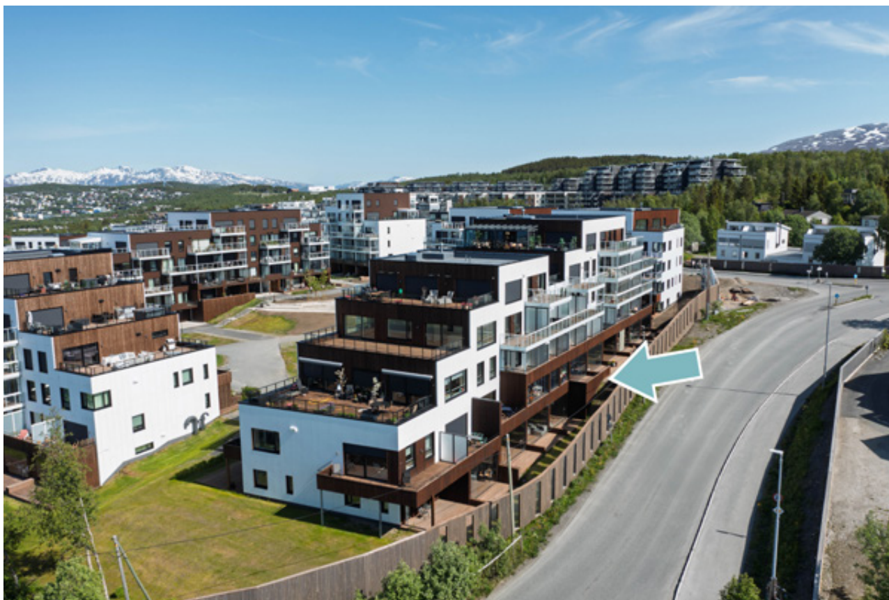
Boligblokk EIR - sett fra sør
