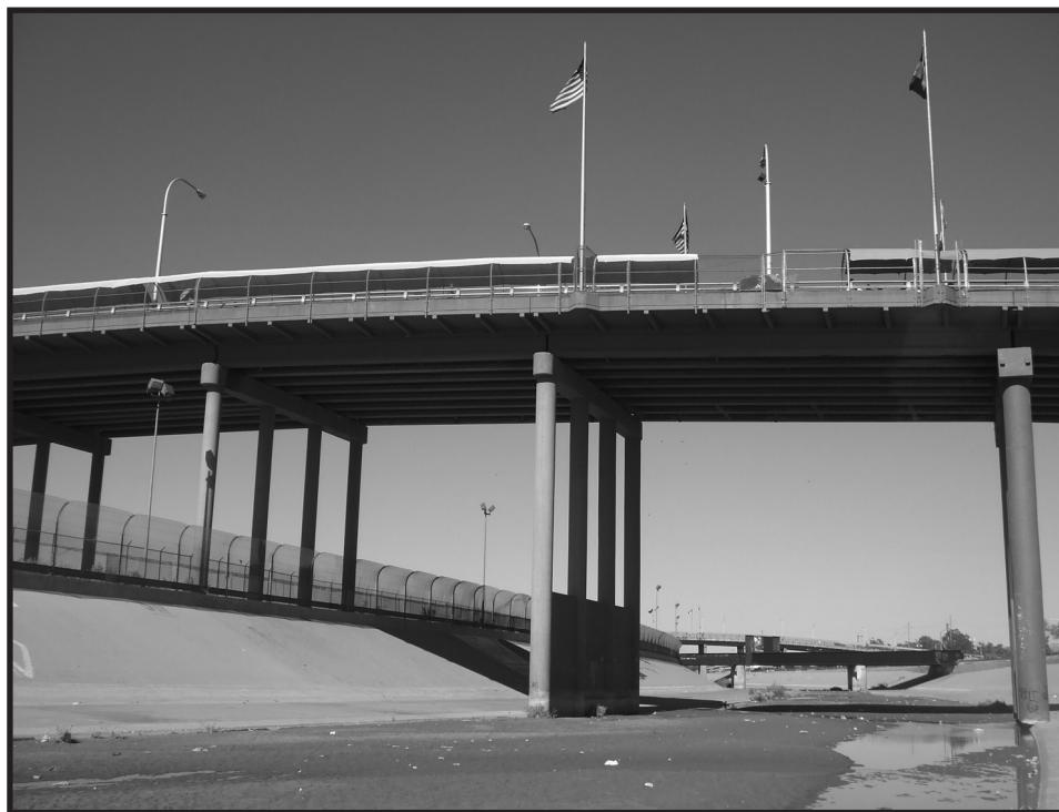
Concrete culvert separating Ciudad Juarez, Chihuahua, Mexico, and El Paso, Texas, United States.
