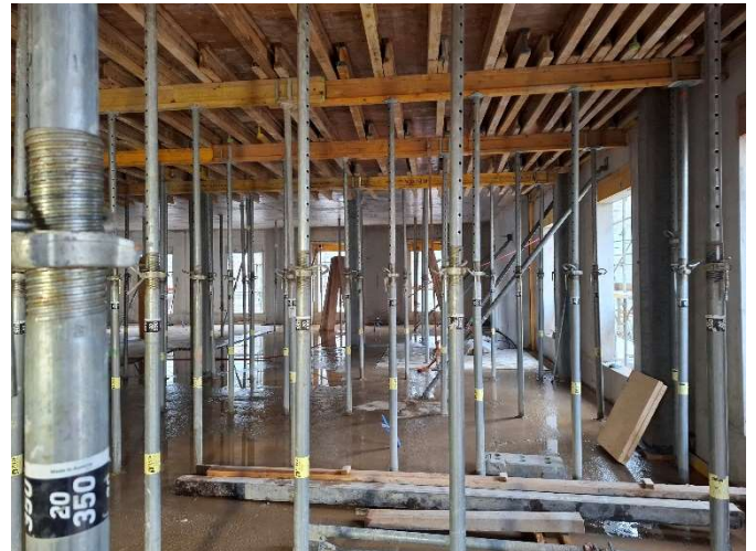
Betonierte Decke über dem ersten Untergeschoss im IRM Neubau an der Socinstrasse
