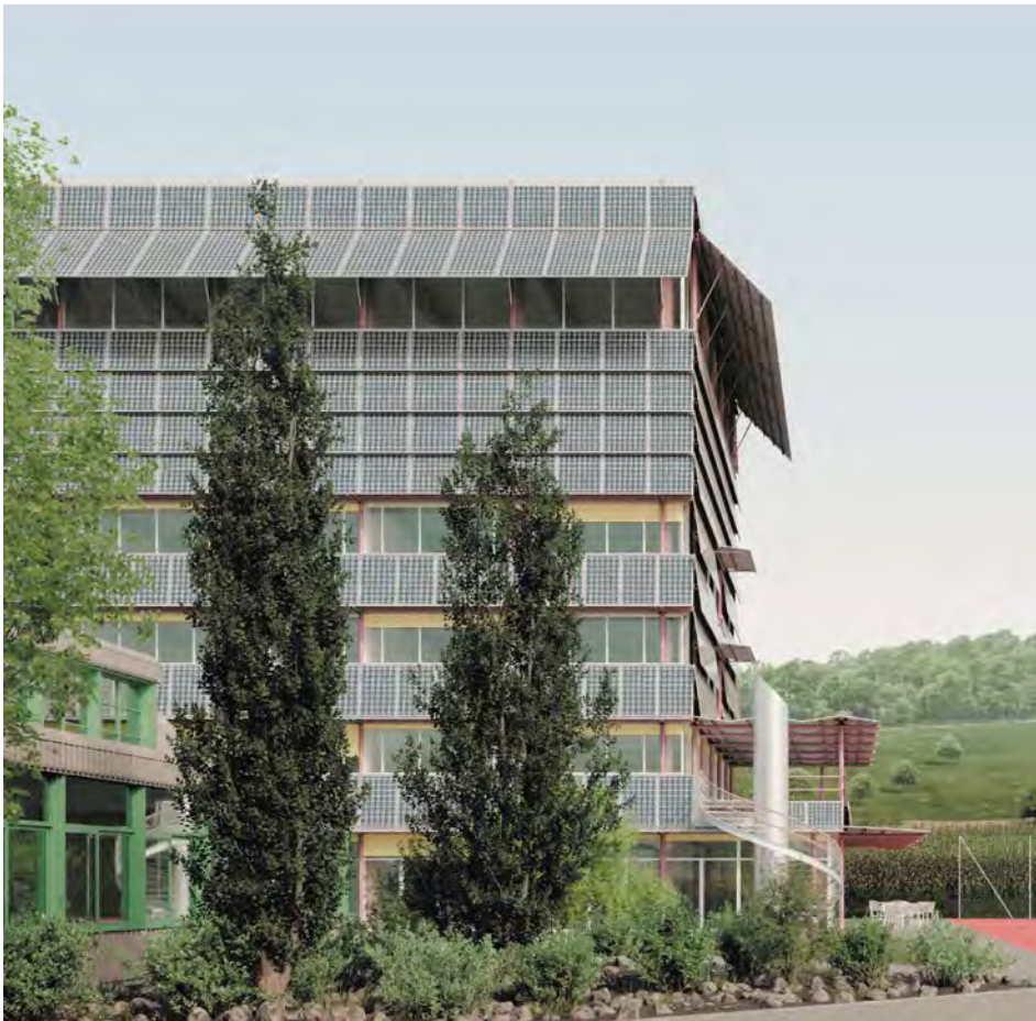
Der Erweiterungsbau steht hinter dem bestehenden Berufsschulhaus und überragt dieses sehr deutlich.
