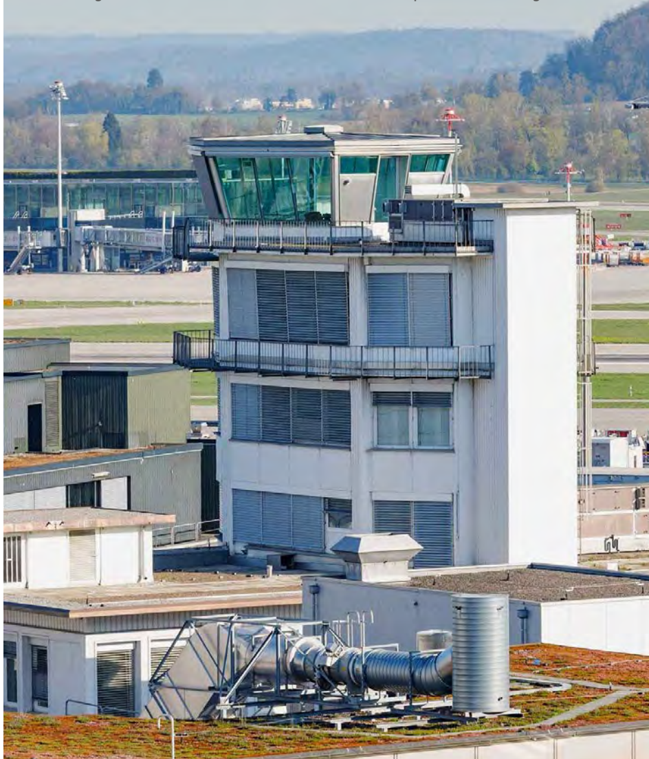
Der alte Tower am Flughafen Zürich: kompakter Baukörper mit aufgesetzter Kanzel, Teil des Flughofs aus den 1940er-/50er-Jahren und Beispiel der Nachkriegsmoderne.
