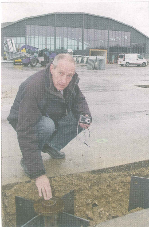
ScrewFast skruepæle på rækker blev skruet tre-fire meter ned i undergrunden, før bagageteltene blev rejst i Kastrup.
