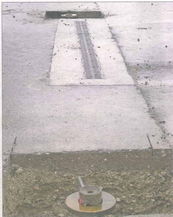
ScrewFast skruepæle på rækker blev skruet tre-fire meter ned i undergrunden, før bagageteltene blev rejst i Kastrup.
