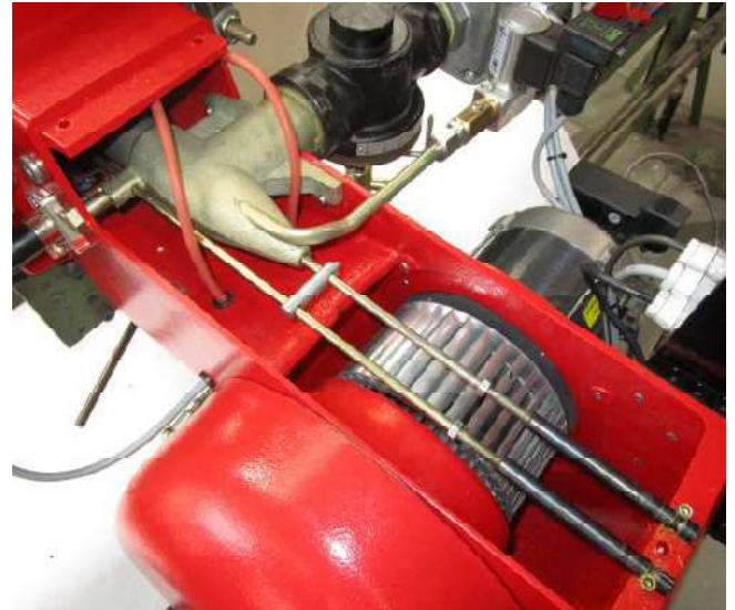
Ausbau des Gasdüsenstocks
