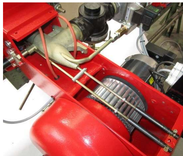
Fig. 30 Ausbau des Gasdüsenstocks
