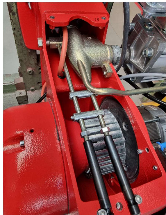
Fig. 30 Ausbau des Gasdüsenstocks
