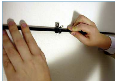
Fixierschelle einsetzen, und montieren
