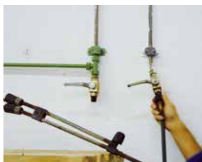
Die Halle ist mit einem Verrohrungssystem ausgestattet, das mehrere Abnahmestellen bietet. Dadurch benötigt der Mitarbeiter nur kurze Schlauchlängen für seine Arbeiten.
