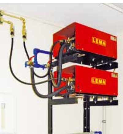
Die Halle ist mit einem Verrohrungssystem ausgestattet, das mehrere Abnahmestellen bietet. Dadurch benötigt der Mitarbeiter nur kurze Schlauchlängen für seine Arbeiten.
