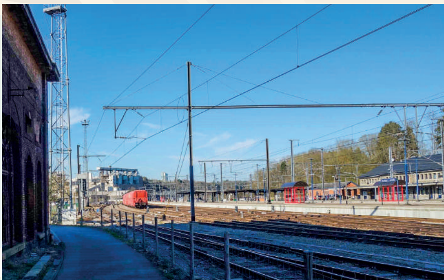
Gare et industrie Lhoist.
