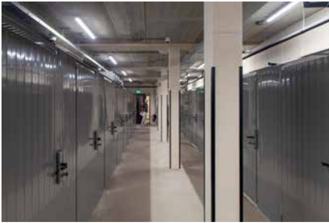
Verdieping met bergkasten
