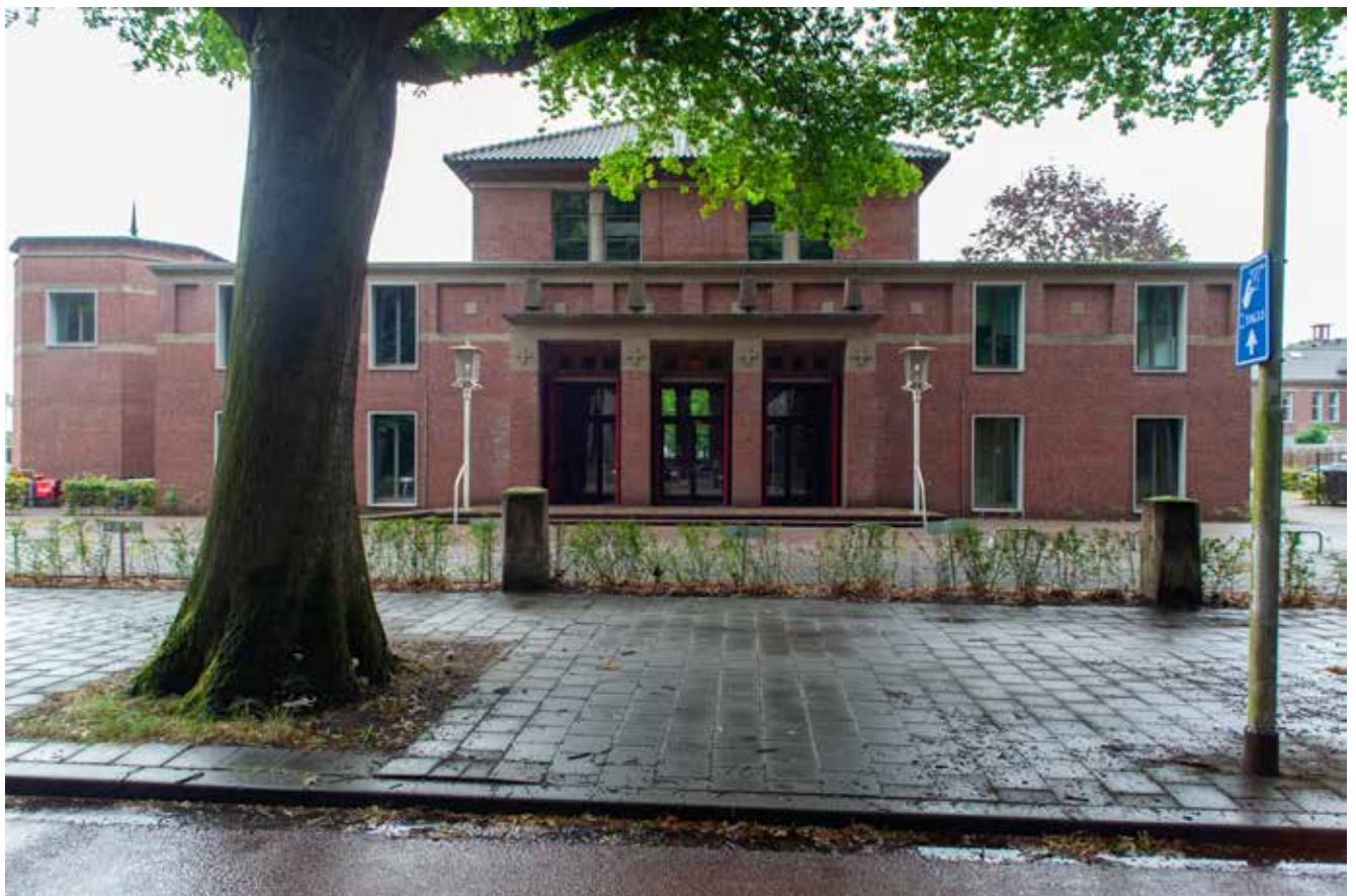
De getransformeerde Vredeskerk
