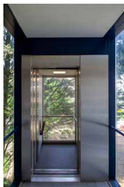
Nieuwe lift met zicht op de tuin
