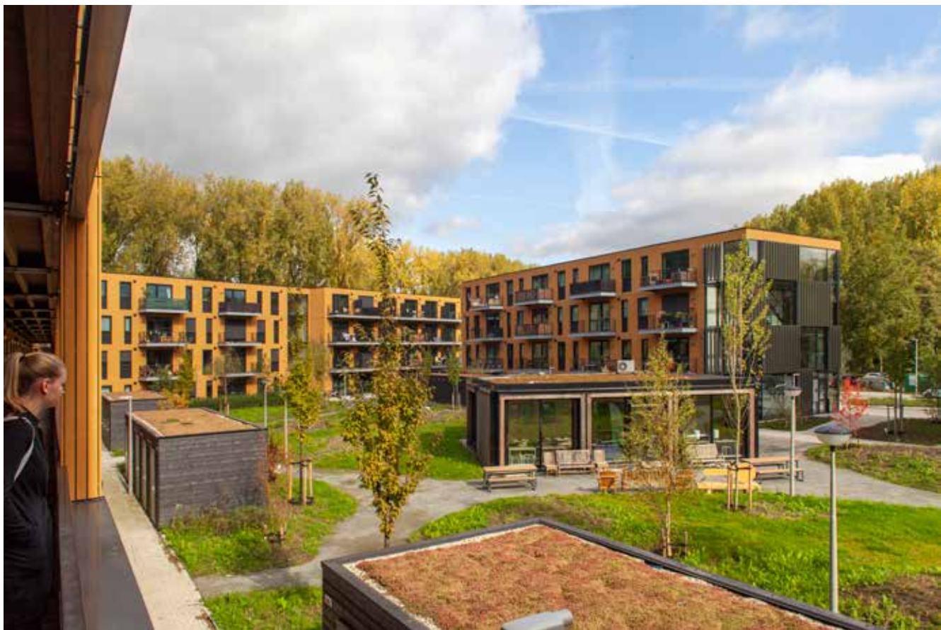
Vanaf de galerij is goed zicht op het paviljoen.
