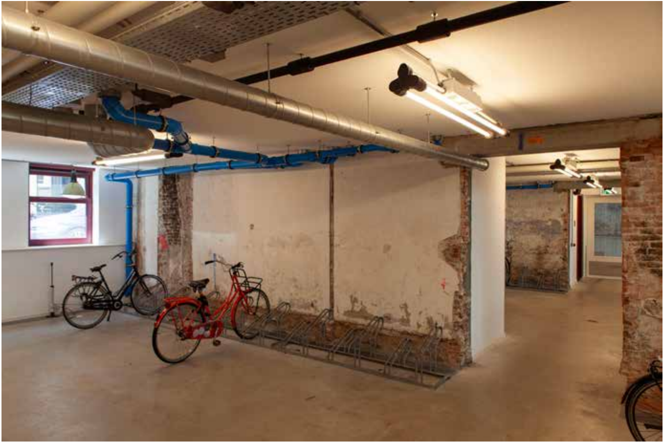
De souterrains zijn doorgebroken tot een gezamenlijke fietsenstalling. Vanuit de gemeenschappelijke ruimte is volop zicht op de fietsenstalling.
