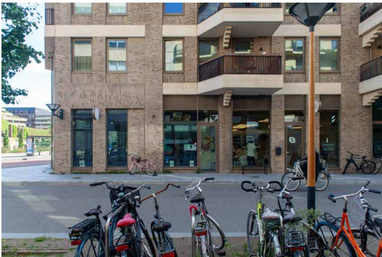
Op de hoek van een van de bouwblokken ligt de buurtkamer.
