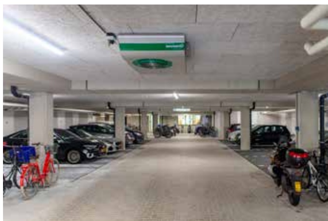
Parkeergarage onder een van de bouwblokken
