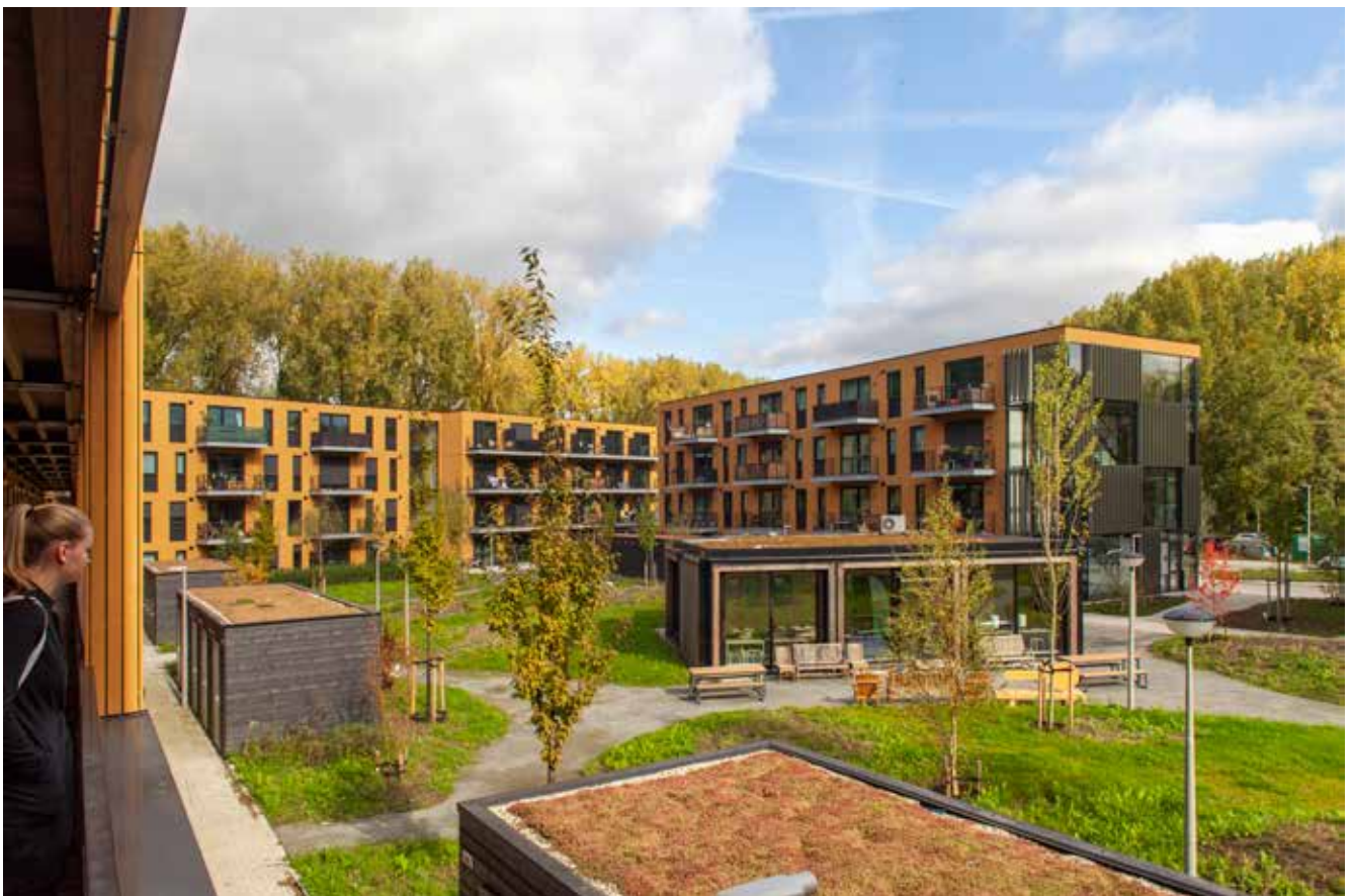
Aantrekkelijke kwaliteit van modulaire flexibele bouw in CLT van het project Merwijde.
