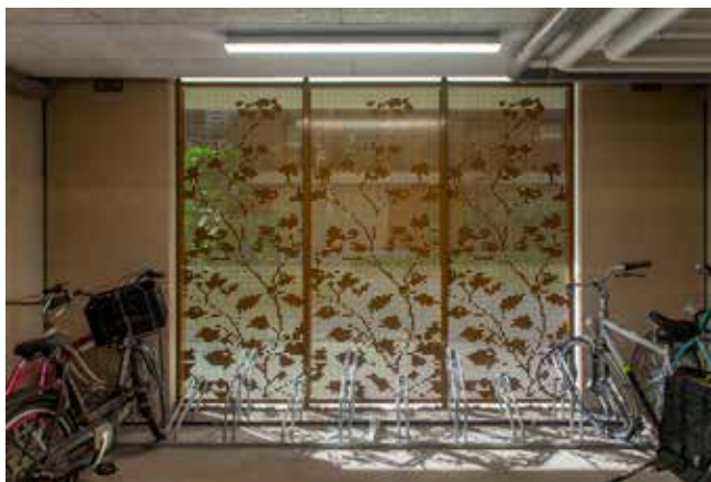
De fietsenstalling heeft daglicht en is afgesloten met een fraai geperforeerd rooster.
