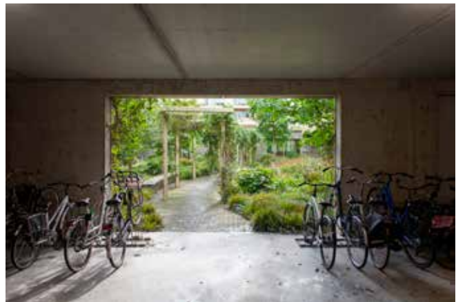
De fietsenstallingen van Eenhoorn staan in directe verbinding met de tuin. De route door de tuin leidt naar de entreehal
