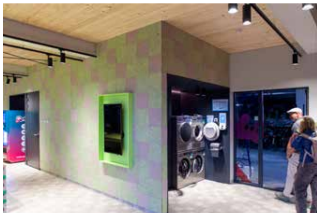
Wasmachines staan in de entreehal opgesteld
