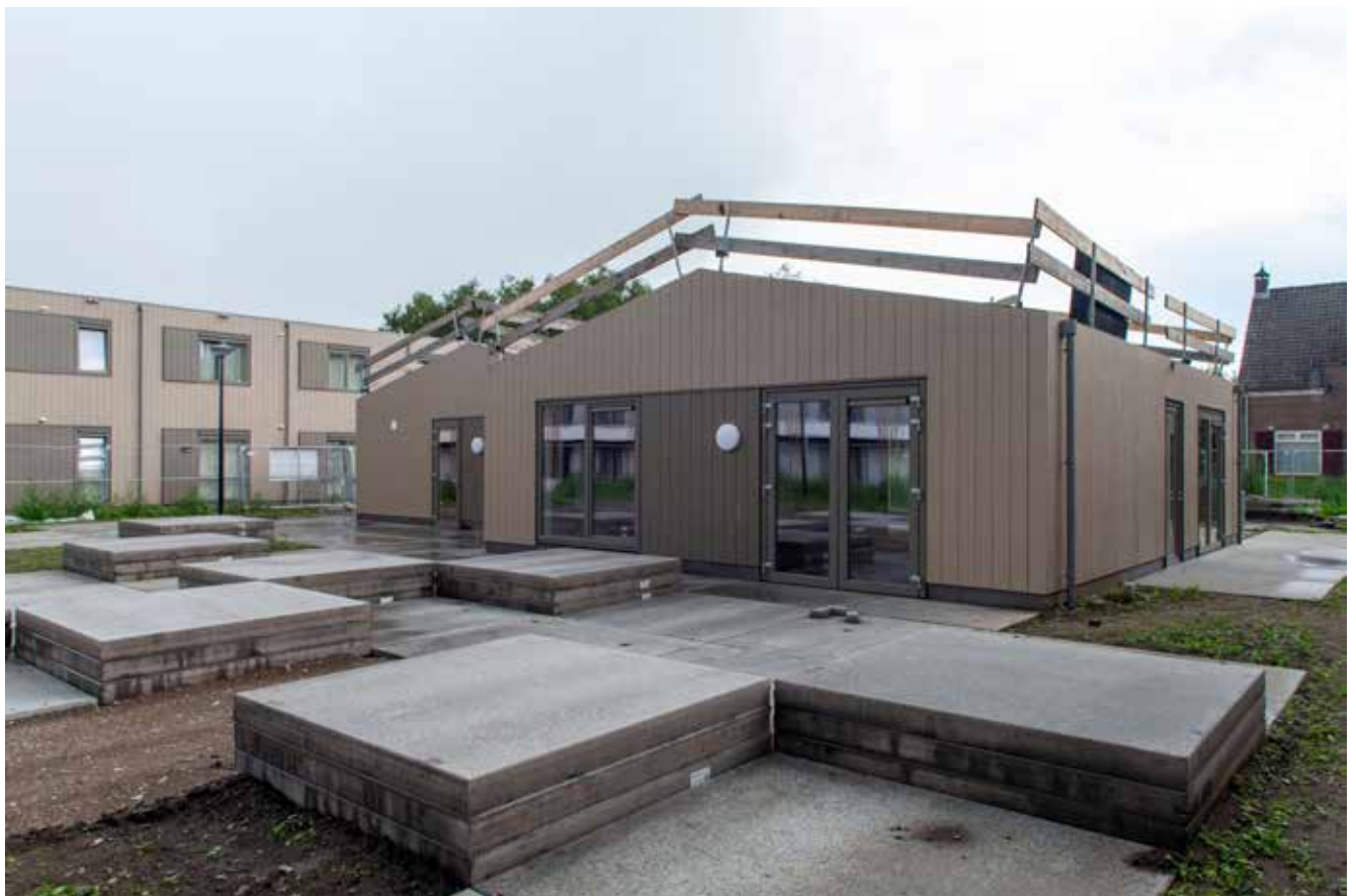
Het paviljoen, de gemeenschappelijke ruimte, in aanbouw.
