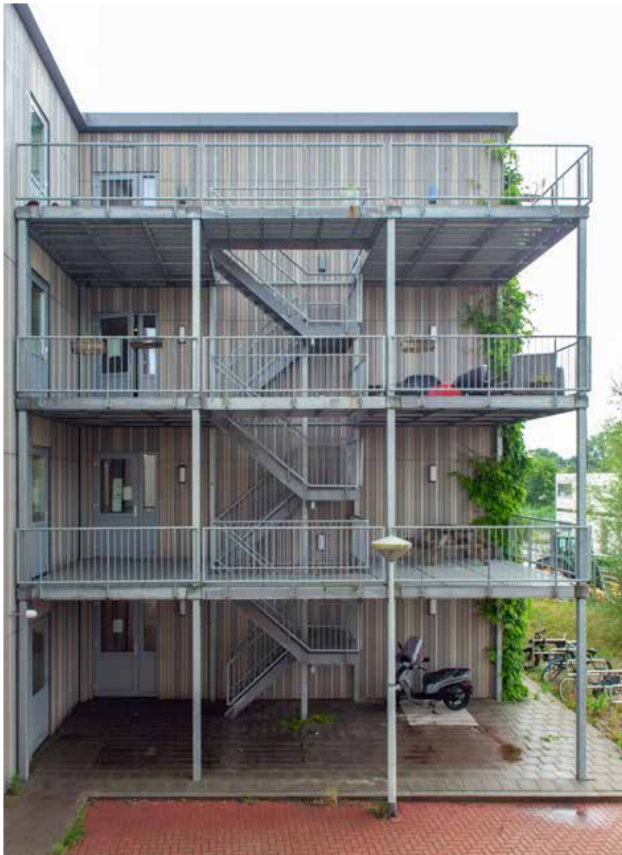
Balkons zijn gecombineerd met de vluchttrap.
