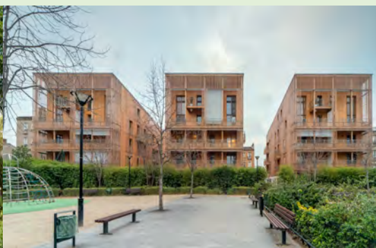
Photo de l'opération réalisée en février 2015 (document Agence Tectône)
