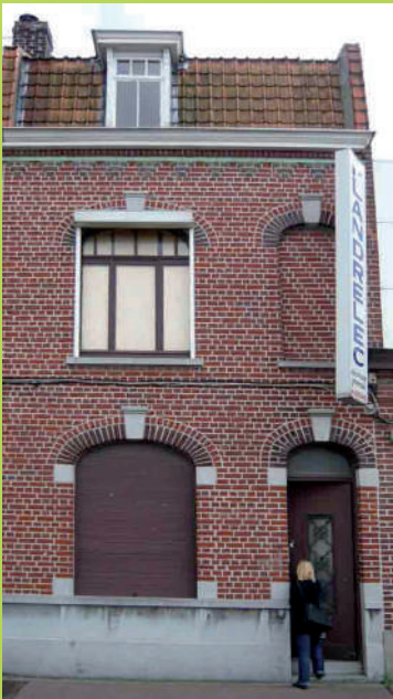
Vue d'une façade restaurée sur rue
