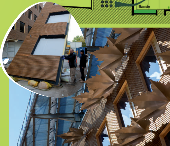
Pose des panneaux préfabriqués et détail de la façade Sud avec les brise-soleil
