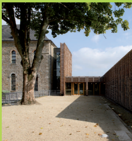
Vue de la cour d'entrée
