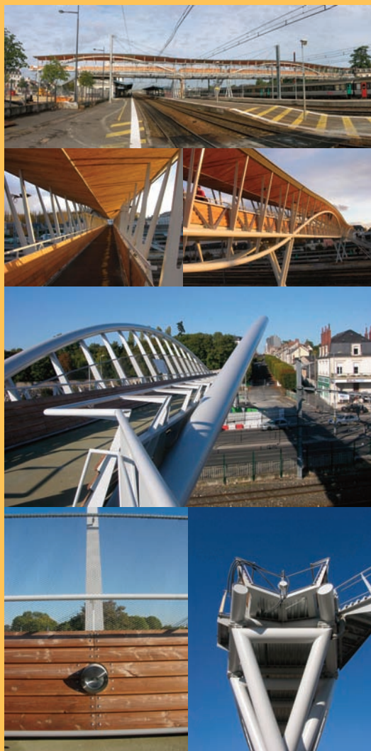
Les deux passerelles réalisées
