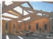
Construction bois, cantine à Brettville (14)
