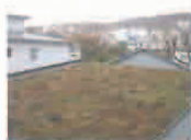
Toiture végétalisée, crèche - Cherbourg (50)
