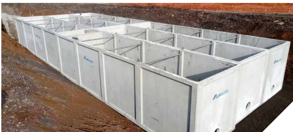
Vasche per impianti trattamento acque
