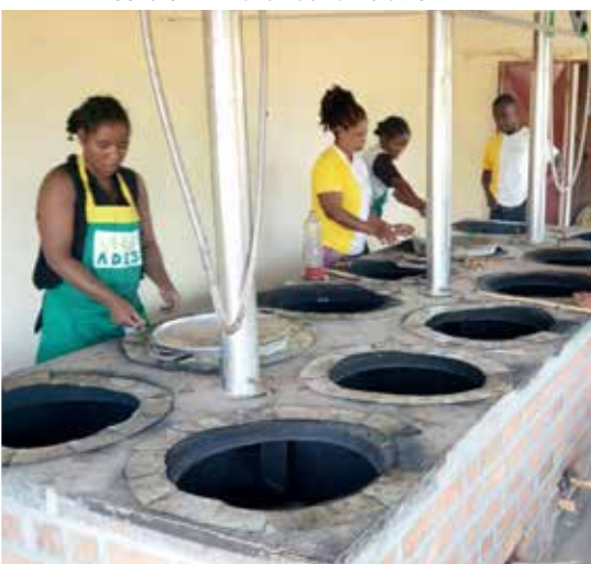
Kochherde werden an der Les Saphirs Schule in Antohamadiro installiert.
