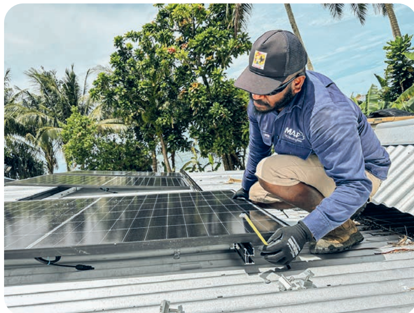
Installation des panneaux solaires sur le toit du centre de santé
