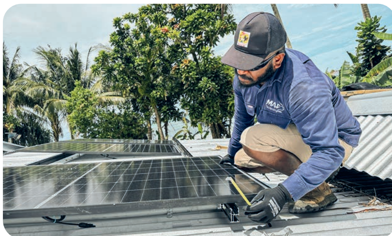
Installation der Solarpanels auf dem Dach des Gesundheitszentrums
