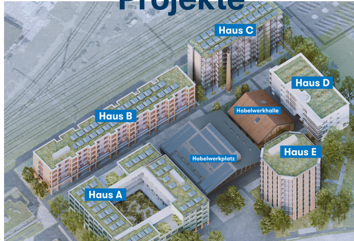
Insgesamt fünf Neu- und zwei Umbauten entstehen auf dem Areal Hobelwerk in Winterthur. Ziel sind möglichst tiefe THG-Emissionen in Erstellung und Betrieb. Quelle: Nightnurse Images AG
