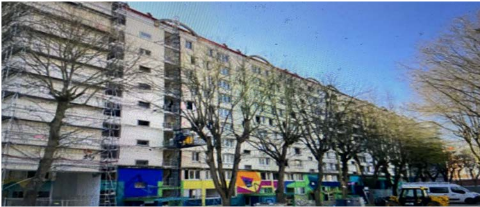
L'immeuble B, bâtiment emblématique de St-Lucien a été démoli dans le cadre de la rénovation urbaine du quartier.
