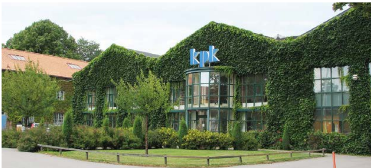
Kontorets glasade entré tillkom under slutet av 1900-talet. Murgrönan på fasaderna utgör ett karaktäristisk inslag i miljön. (Bild från år 2009).
