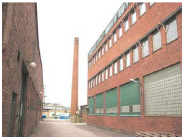
Panncentralens höga skorsten gör byggnaden till ett landmärke i området. Fotografi mot nordväst.
