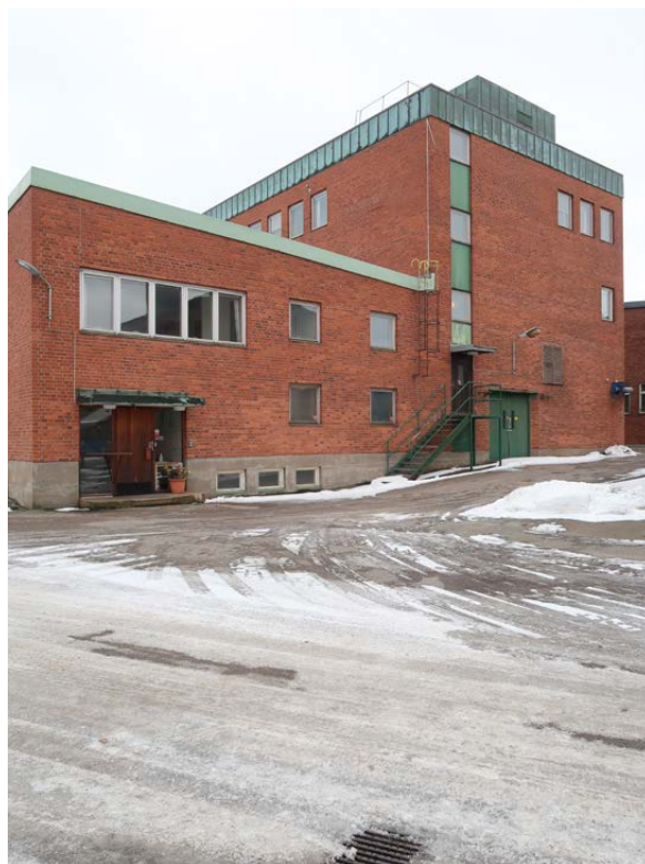
Kontors- och verkstadsbyggnadens fasad mot nordväst.
