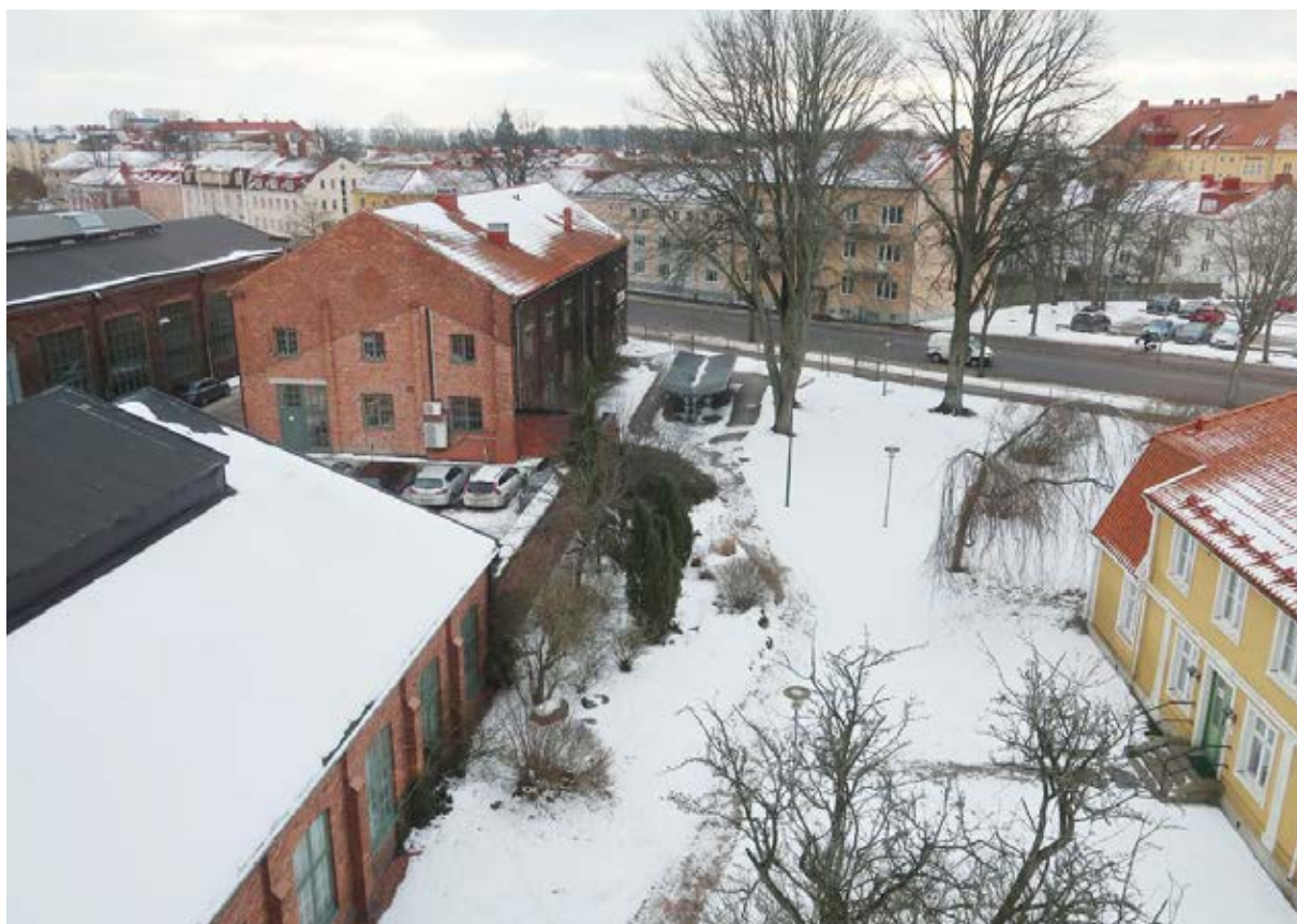
Vy mot söder från kontoret visar delar av den gamla malmgårdstomten runt villan samt kärnområdet i kvarteret, med röda industribyggnader. Här framträder också den gamla infartsvägen till tomten från Södra vägen.
