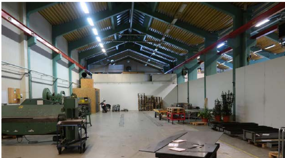
I byggnadsdelarna från 1940- och 50-talet är den bärande konstruktionen utförd av armerad betong. Hallarnas takfönster är idag igensatta.
