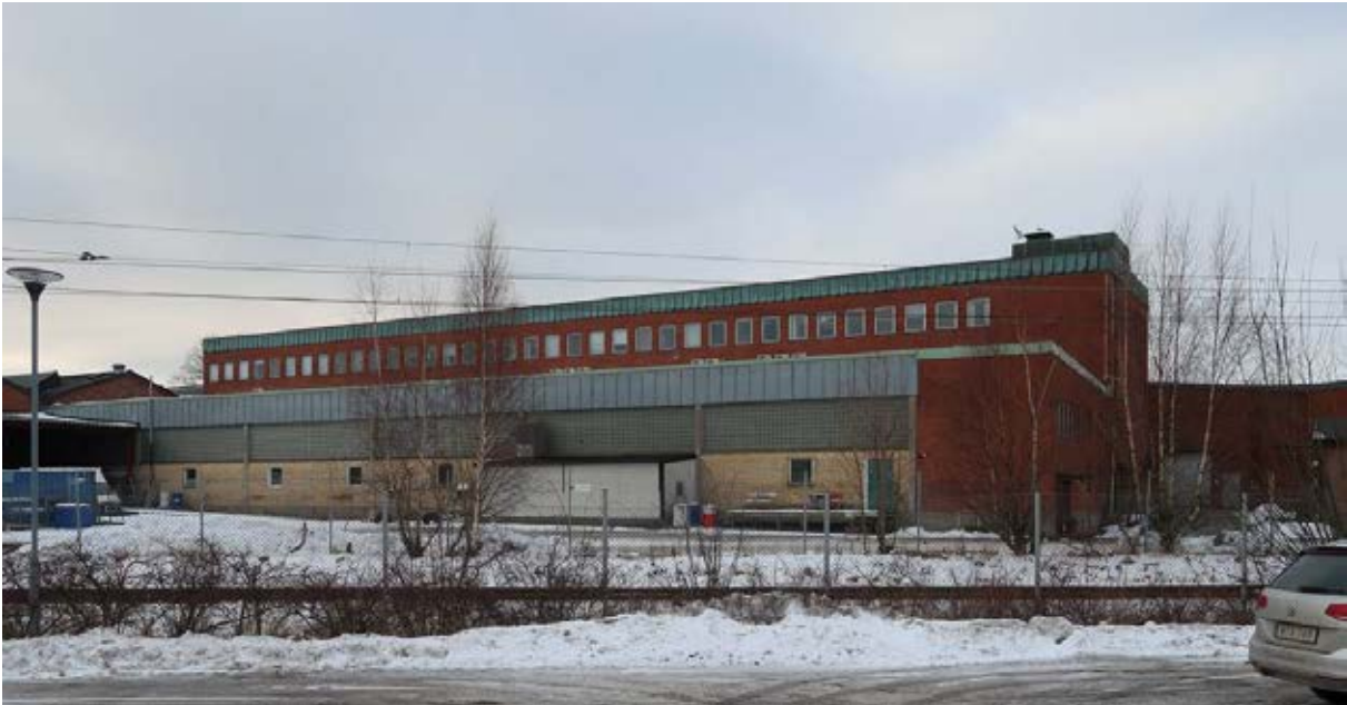
Kontors- och verkstadsbyggnaden fotograferad från nordost, med järnvägen i förgrunden. Den lägre byggnadsvolymens fasad mot nordost är klädd gult tegel. Över tegelväggen löper ett långt band av glasbetong.
