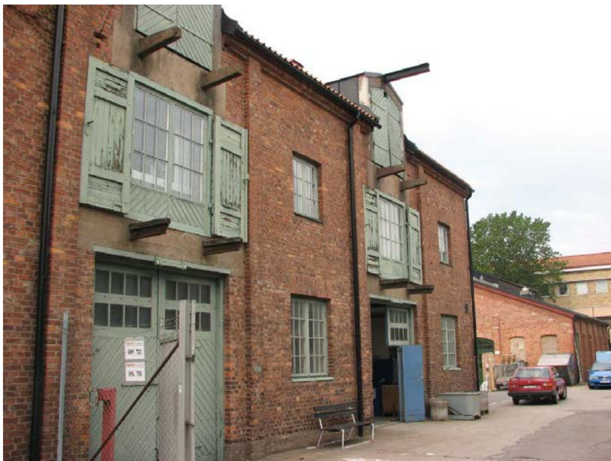
Husets östra långsida vetter in mot en smal lokalgata mellan verkstadshusen. (Bild från år 2009). Hissbommar och luckor in till vinden ger karaktär åt byggnaden.
