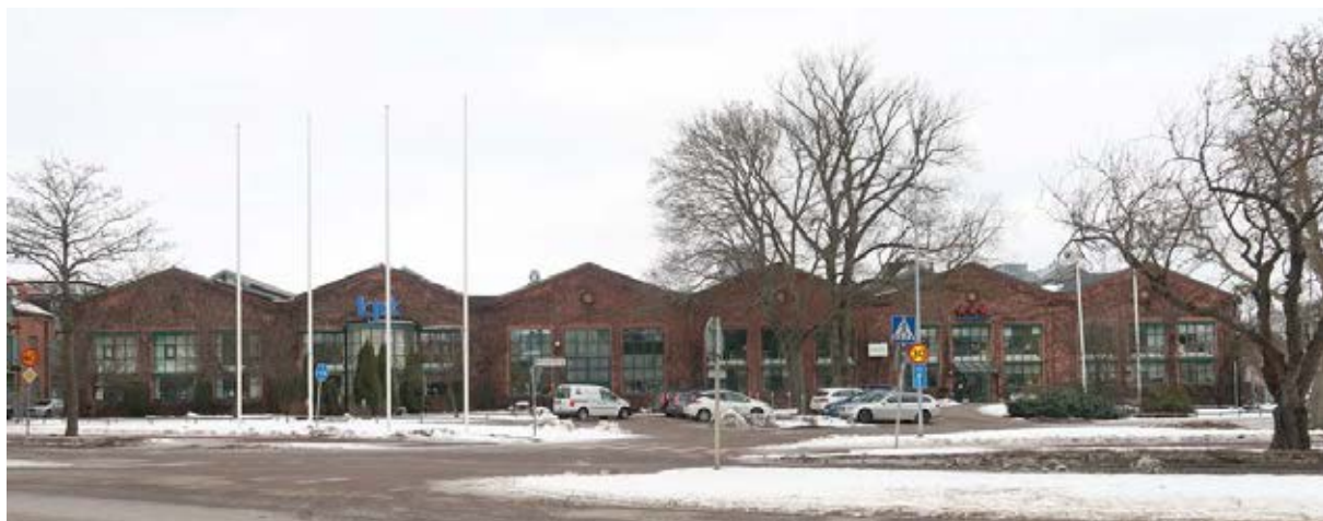
Fasader mot Södra vägen. De sex gavlarna har tillkommit två och två i tre etapper. De båda gavlarna längst åt väster, till vänster i bild, uppfördes omkring 1930. De följande utbyggnaderna gjordes efter byggnadslov 1945 och 1950.
