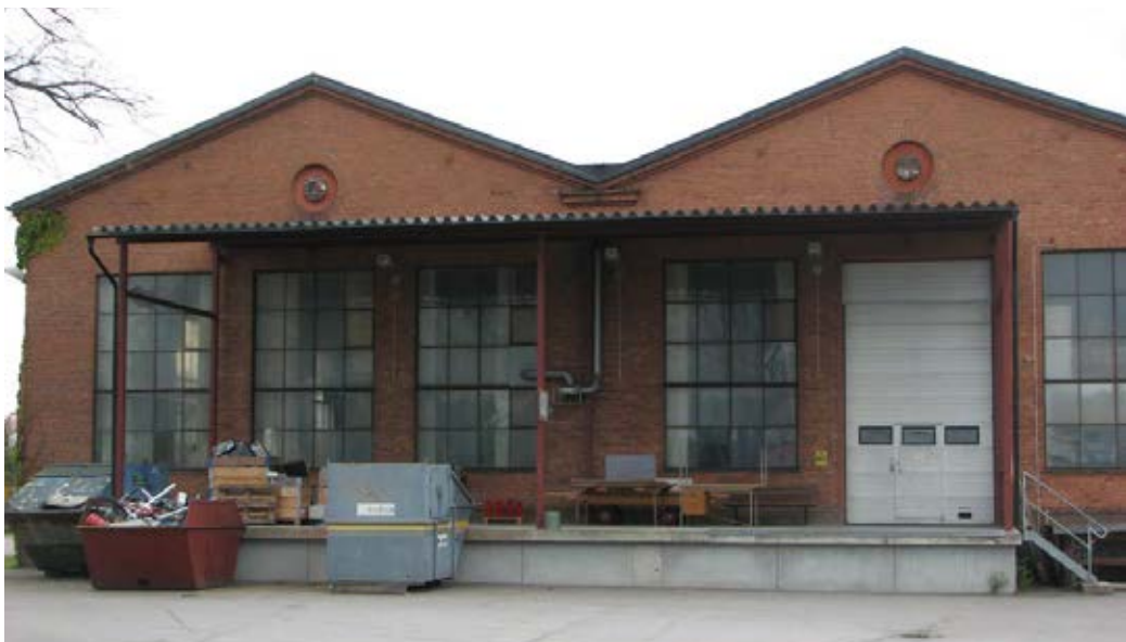
Enkla, smäckra plåttak som signalerar industri får gärna behållas eller användas som förlaga där skyddstak behövs på andra ställen i området. Del av fasad mot nordväst. (Bild från år 2009).
