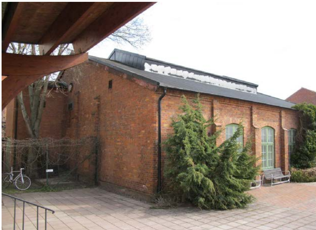
Verkstadsbyggnadens västra sida ingår sedan slutet av 1950-talet som en viktig rumsskapare i utemiljön framför kontorsbyggnaden. Här finns en anlagd utemiljö med markplattor och planteringar (Bild från år 2011).
