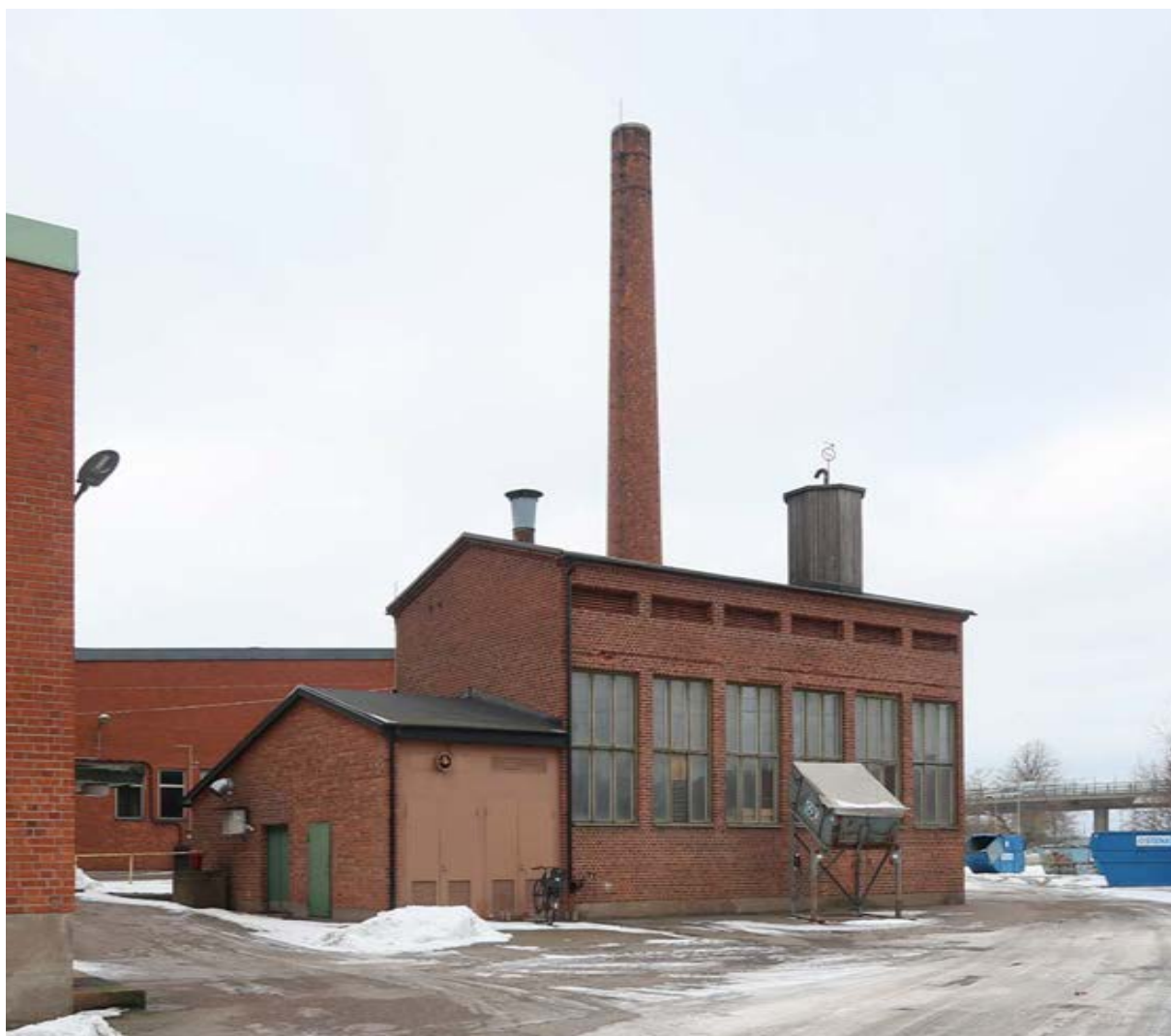
Panncentralen sedd från öster.
