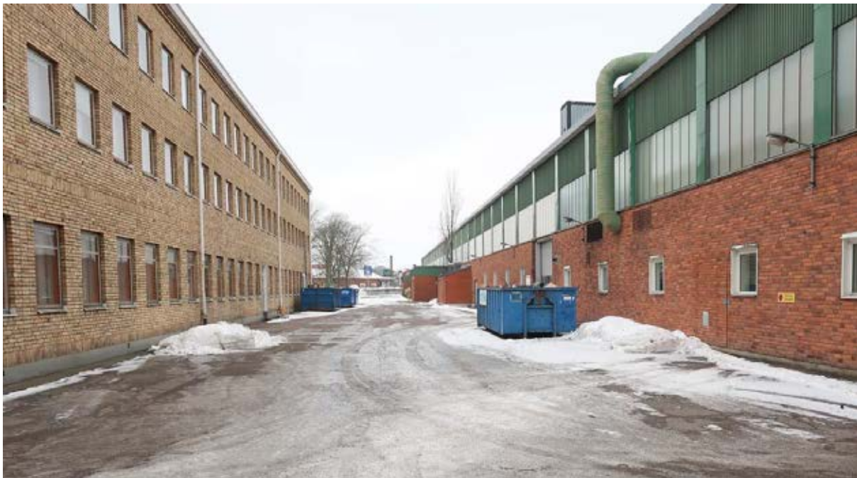
Fotografi mot sydväst taget mellan kontorsbyggnaden från mitten av 1950-talet och verkstadsbyggnaden från tidigt 1960-tal.
