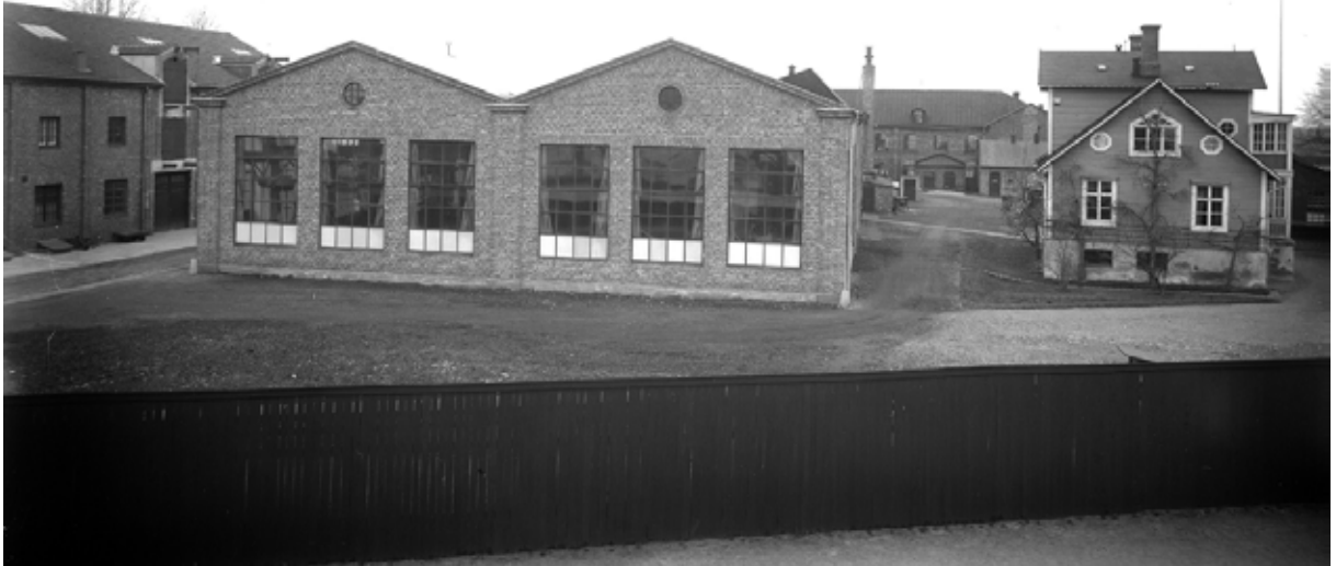
Foto från år 1934. Maskinhallen efter nyligen genomförd förlängning mot sydväst. De två gavlarna finns kvar än idag, men huset har etappvis byggts på med ytterligare fyra gavlar eller "skepp", i samma stil. Det två våningar höga tegelhuset till vänster i bild finns också kvar. Kontorsvillan till höger revs då industribyggnaden breddades med två skepp mot öster 1947 (byggnadslov 1945). Runt tomten fanns ett enkelt träplank. Foto: Kalmar kommun.
