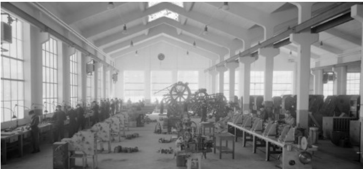
Fotografi mot söder från i en nyuppförd del av Sifvert & Fornanders verkstadshallar 1947. Hallarna byggdes ut i många etapper. Den äldsta delen i nordväst antas vara bevarad från omkring 1860. Sista utbyggnaden gjordes efter byggnadslov 1950. (Kalmar kommuns bildarkiv, GA198).
