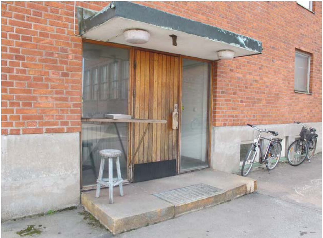
Välbevarad tidstypisk entré mot nordväst. Skärmtaket är klätt med kopparplåt.
