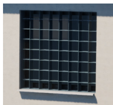
Protection des façades
