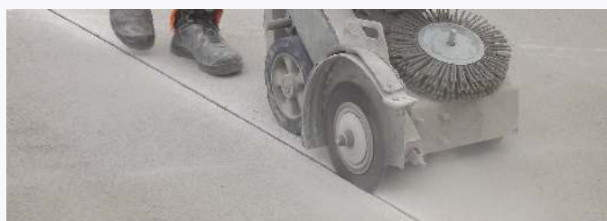
Voegenborstel gebruikt in de wegenbouw
